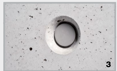
Verschluss Mauerstärke mit Konus
