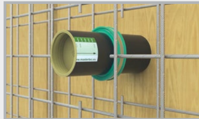
Das Futterrohr wird an der Schalung angebracht.
