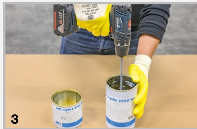
3 Die Mischung für mind. 2 Minuten aufrühren.
