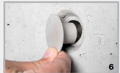
Nach dem Tiefsetzen des STOPPER in lässt sich ein Konus einkleben.
