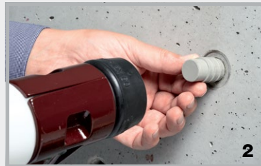
Der STOPPER in wird mit einem 1500 – 2000 g Hartgummihammer eingeschlagen.
