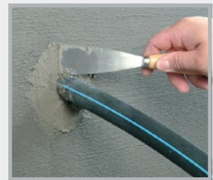
Verspachteln mit Schnellzement
