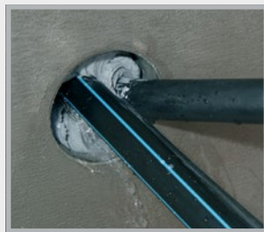
Füllen des Ringspaltes
