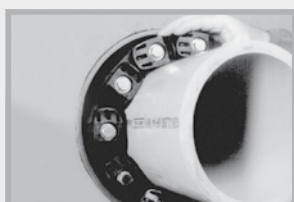
MASTER-SEAL in den Ringspalt einschieben
