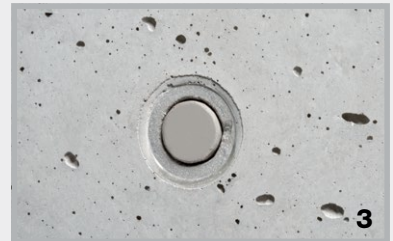
Bündiger Verschluss bei Mauerstärken mit Dichtlippe.
