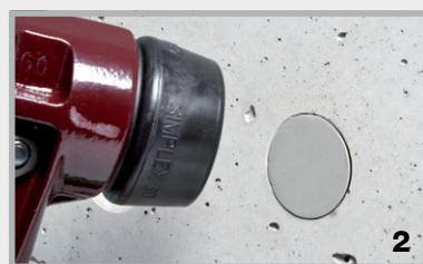
Einschlagen mit dem Gummihammer
