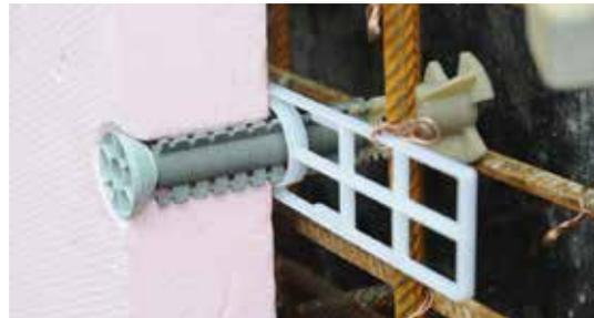
Verwendung der UNI-Betonhülse mit Montageplatte und Verlängerungshülse bei Isolationseinlagen in der Schalung.
