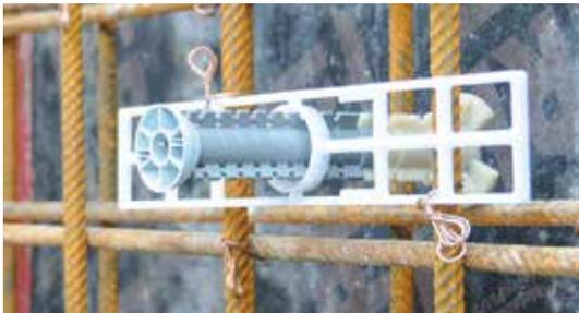
Bei Verwendung mit Montageplatte und Verlängerungshülse wird die Einbautiefe und somit die garantierte, zugelassene Gebrauchslast auf 4'500 kg (45kN) erhöht.
